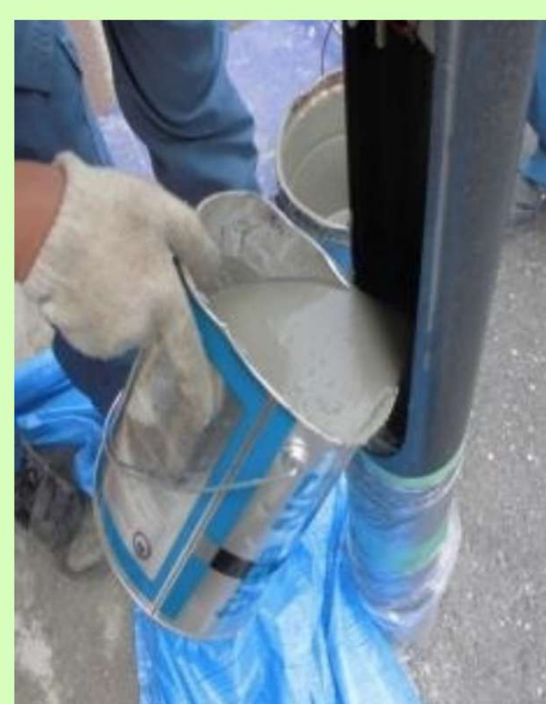
⑤モルタル充填作業
