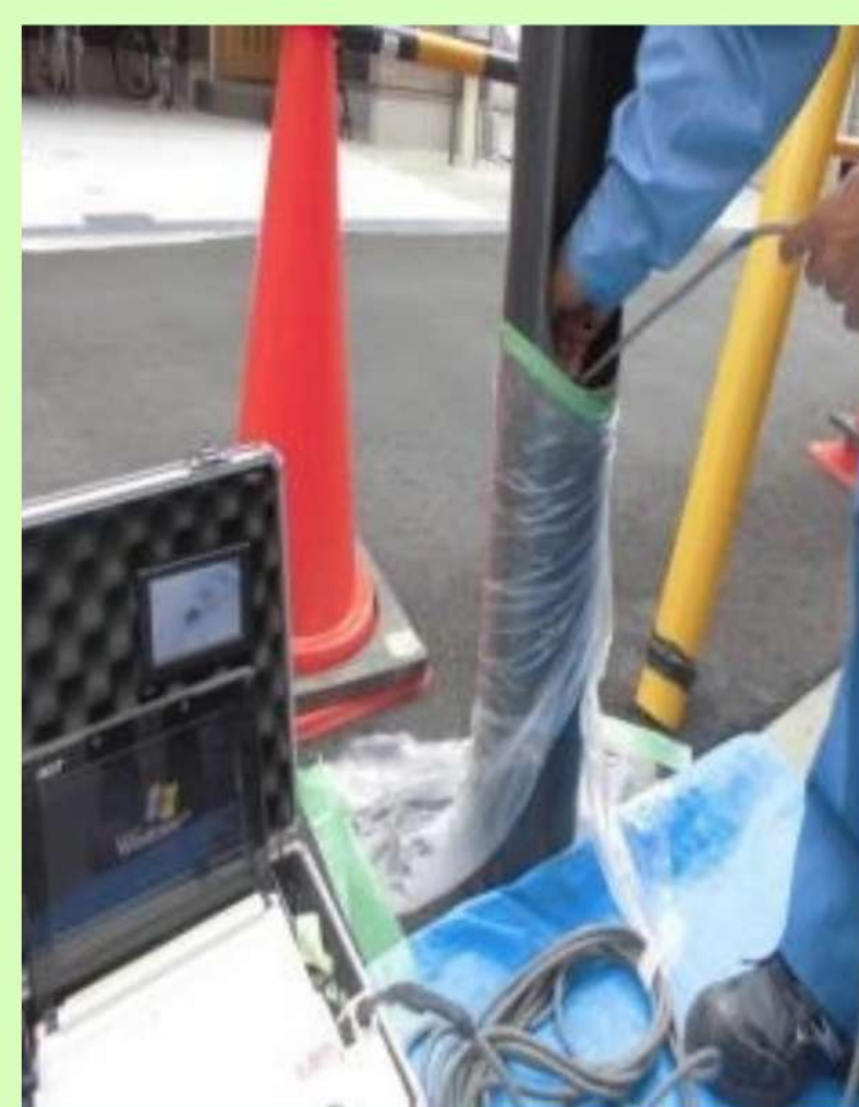
①支柱内の調査等
