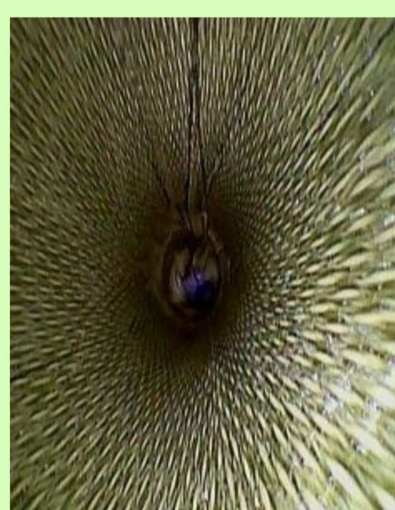
④支柱内の圧着状態
