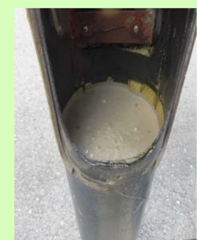
⑥支柱内の充填状況
