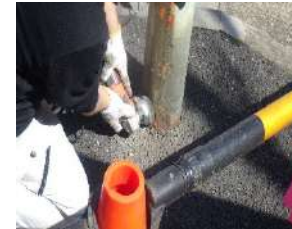
【 2 補修部のケレン 】
