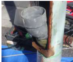
(図3-31) モルタル充填管
