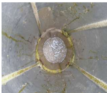
モルタル充填状況-2
