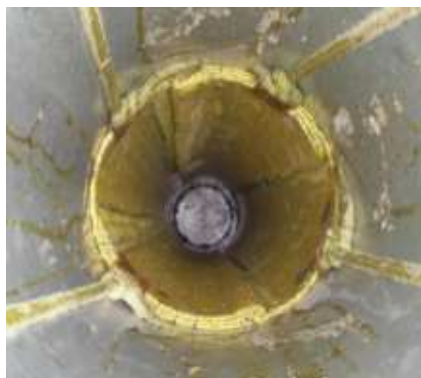
モルタル充填状況-1
