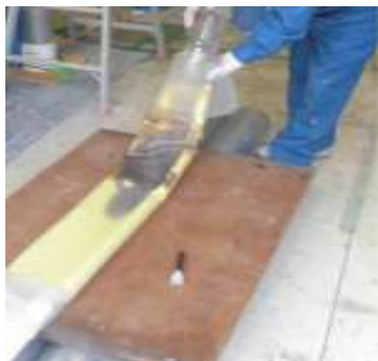
接着剤注入状況
