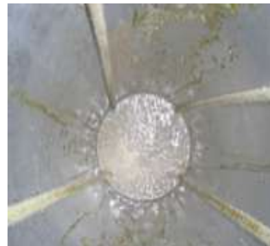
モルタル充填完了状況
