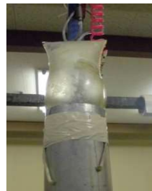
アラミドシート貼付け状況
