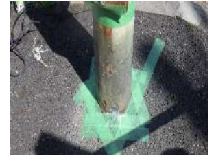
【 3 補修部の養生 】
