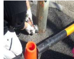
【 2 補修部のケレン 】
