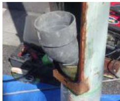
(図3-31) モルタル充填管
