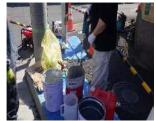
【3 モルタルの攪拌】
